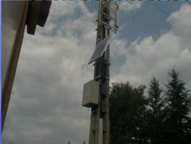
Relais WIFI avec Bridge sur panneaux solaires (Pose sur Poteau moyenne tension) EDF . Relais autonome couverture sectorielle
