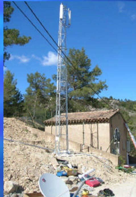
Pylône en construction (Vins 83)
