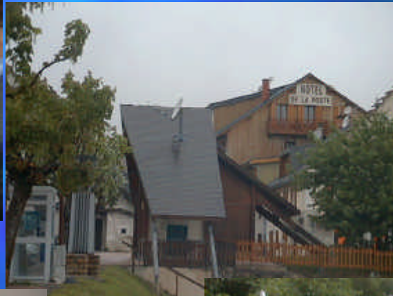
Transformateur « eglise » Autrans
